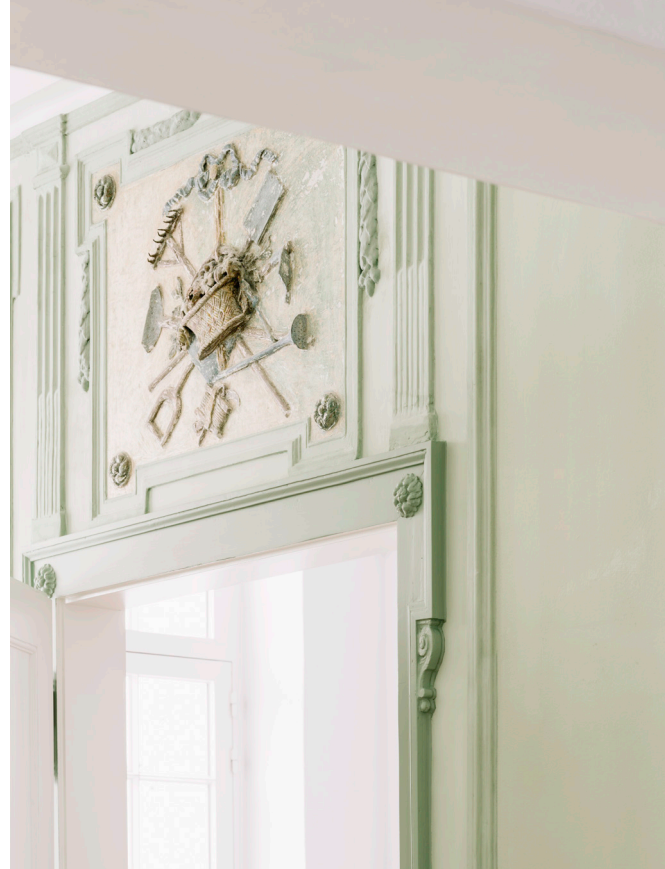
Restauratie 'Landhuis De Blauwe Toren' ©Allt
