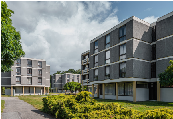
Restauratie 'Theologisch en Pastoraal Centrum' ©Allt Naar ontwerp van arch. Paul Felix (1913 – 1981)
