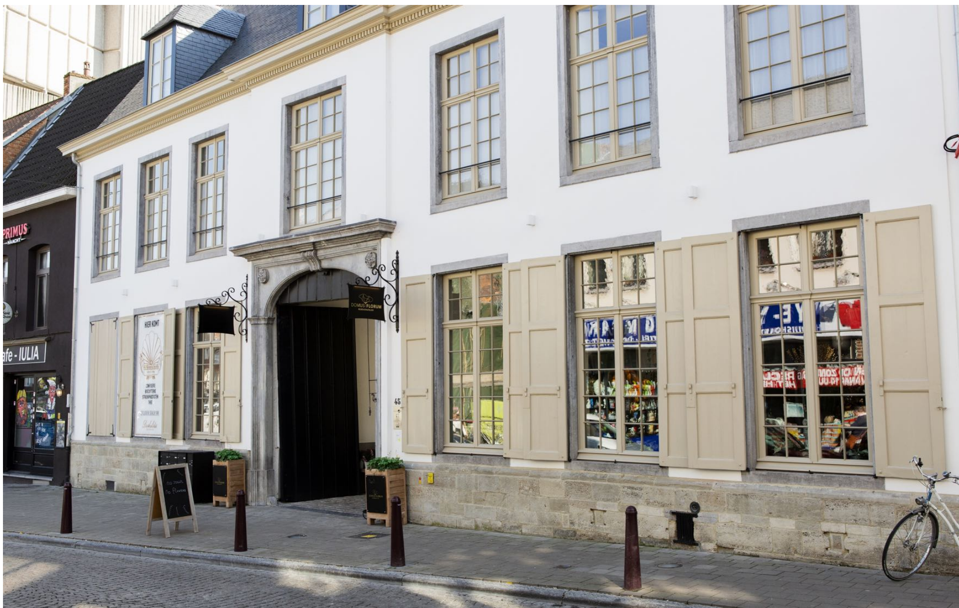
De straatgevel van 'De Gaepaert' is een bekend zicht in het centrum van Aalst. Hij kreeg tijdens de renovatie een nieuwe laag kalkpleister.
