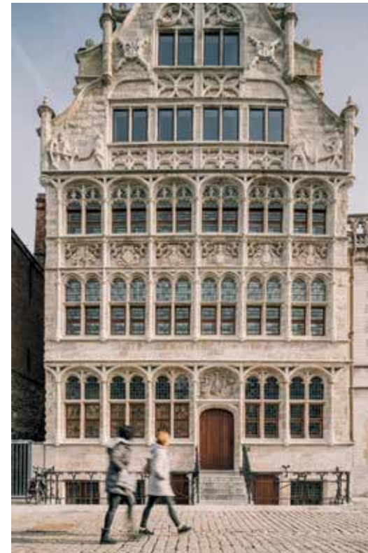
De Balegemse groeve werd opnieuw in gebruik genomen, zodat de hele gevel – op twee beeldhouwwerken na – kon worden gerestaureerd met de originele steen. Ook de ramen zijn gerestaureerd en zelfs volgens de oude methode teruggeplaatst.
