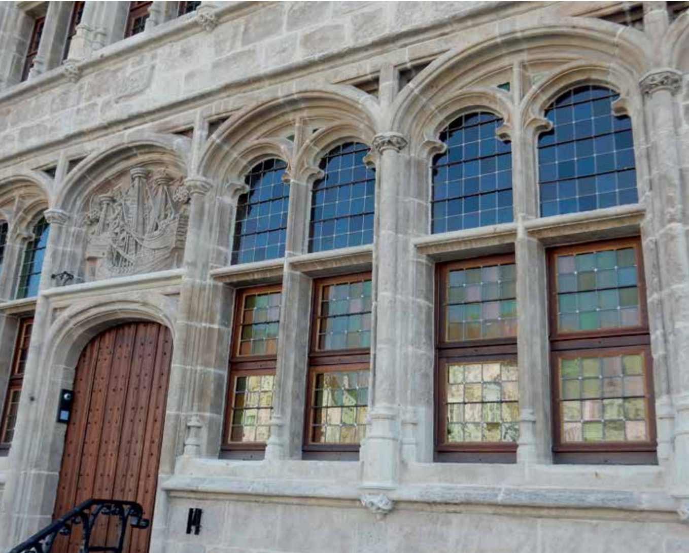
Om het plaatje compleet te maken, zijn de glasramen op een traditionele manier teruggeplaatst, namelijk met behulp van lijnoliestopverf.
